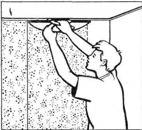
Рис. 233. Можно разглаживать обои пластмассовым шпателем для гладких обоев. Для тисненых обоев с рельефным рисунком применяют щетку
