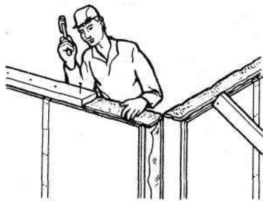
Рис. 108. Установка, крепление и уплотнение верхнего пояса наружных стен
