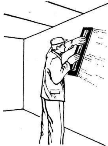
Рис. 210. Выравнивание, затирка оштукатуренной поверхности
