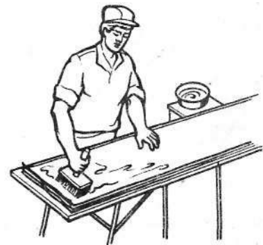
Рис. 231. Нанесение клея на обои
