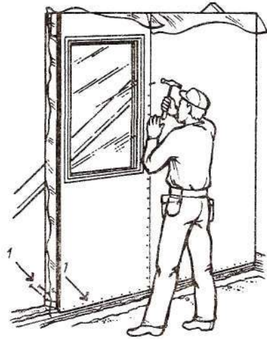
Рис. 31. Монтаж наружной стены из мелко-размерных панелей
